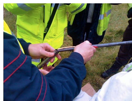
3. Maadoitusköysi lukitaan paikalleen karkaistuun teräskärkeen etuputkella
